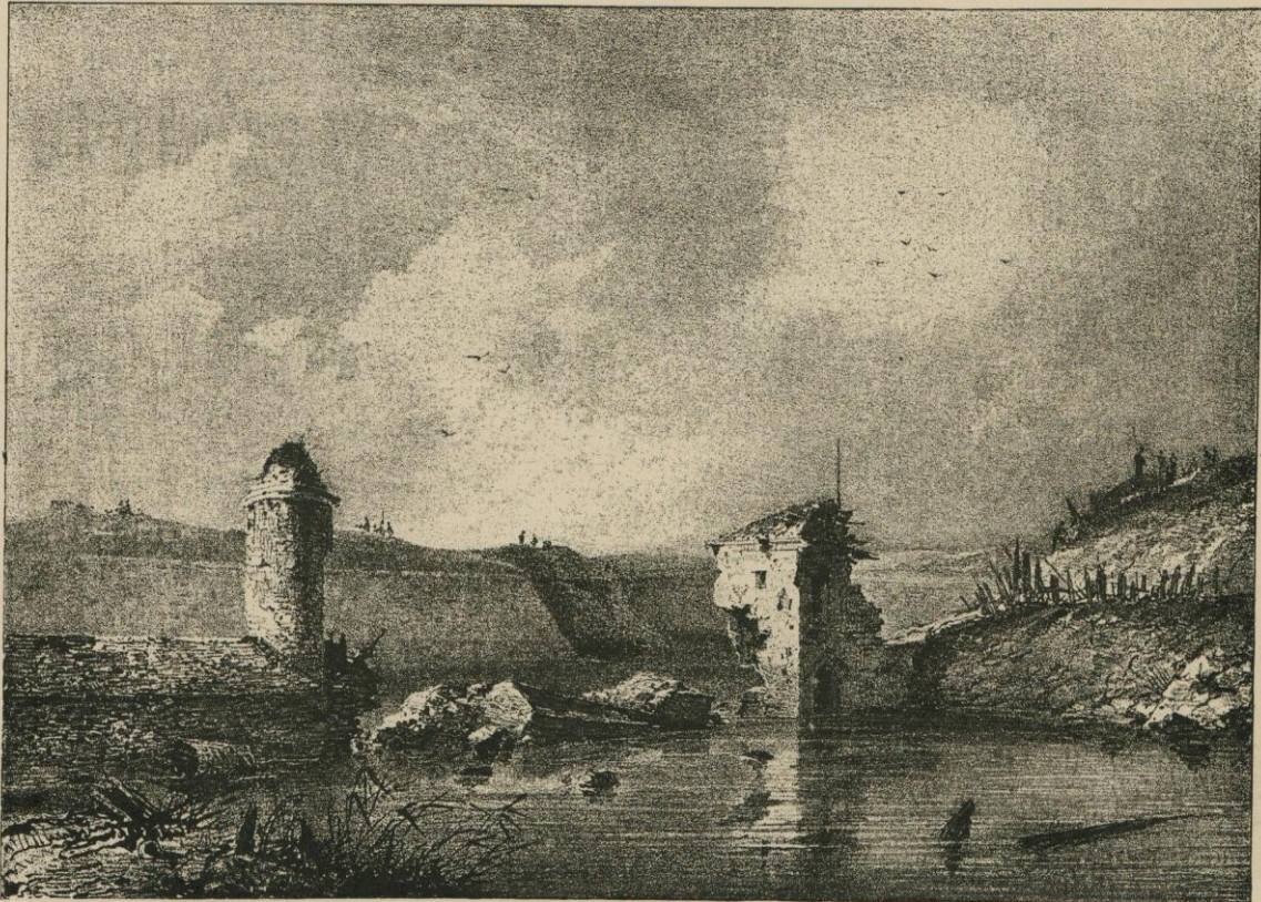
DÉBRIS DU BATARDEAU DE LA CITADELLE D'ANVERS
